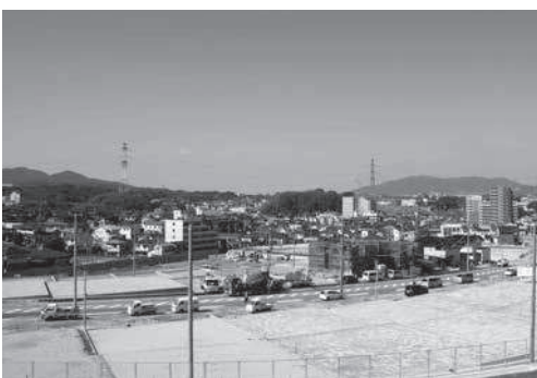
工事が進む都市計画道路筑紫原田線
