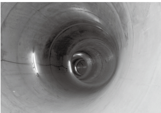
上) スチールフォームの内部。外側にあるトンネルの壁との間にコンクリートを流して補強します。 下) コンクリートで補強されたトンネル内。急曲線が多いトンネルにも対応できるスチールフォームで施工が進んでいます。
