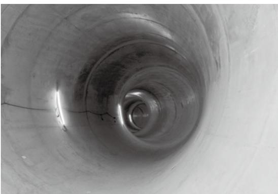
上) スチールフォームの内部。外側にあるトンネルの壁との間にコンクリートを流して補強します。
