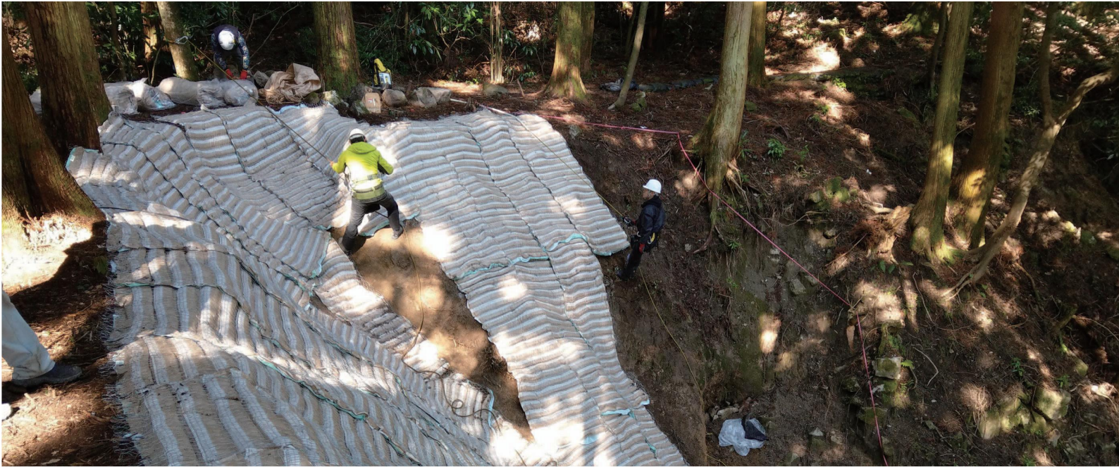
座主跡 災害応急復旧工事状況
