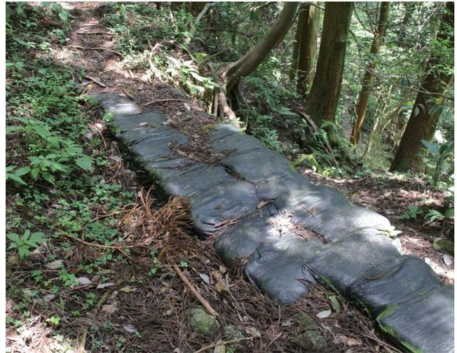
写真 3-30 水害箇所の土のう設置 (坊跡石垣)
