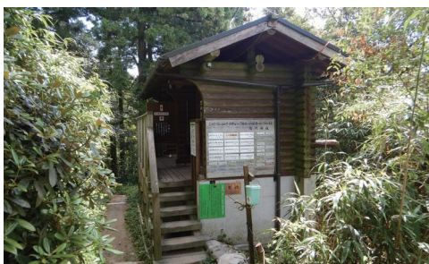
写真 3-20 バイオトイレ
