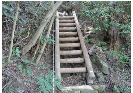
写真3-12 九州自然歩道の階段
