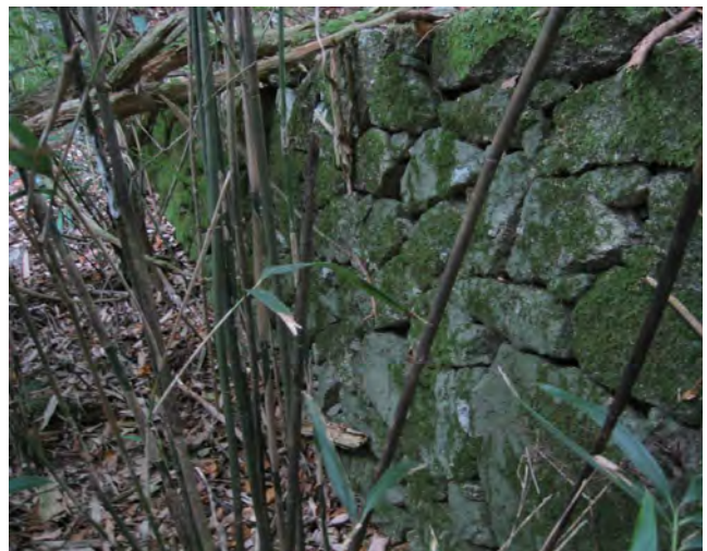
写真 3-14 西院谷坊跡の石垣
