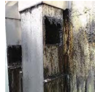
排出口の油汚れ
