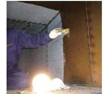
ダクト内の洗浄の様子
