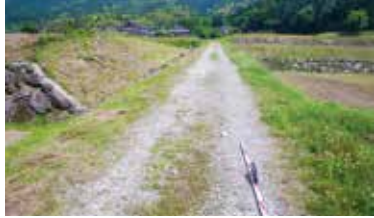
幅員が狭く、勾配が急な箇所が多い砂利道の農道
