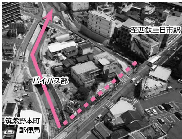
点線部を流れて高尾川に合流していた鷺田川が、バイパス河川に切り替わりました
