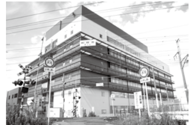
市役所西側、JR鹿児島本線の踏切を移設・拡幅し、交通利便性を高めます
