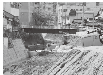
川幅調整のための護岸工事
