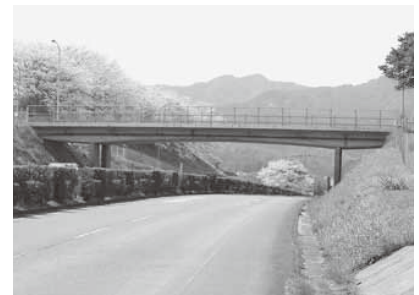
橋りょうの調査と維持補修を計画的に実施しています
