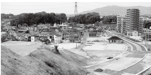
宅地・道路をつくっています
