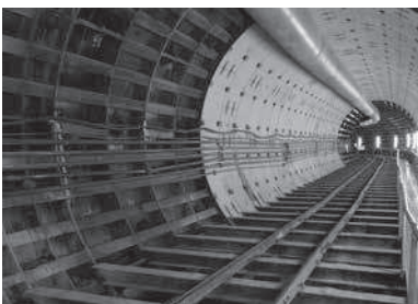
平成30年8月から掘削が行われている高尾川地下河川築造工事
