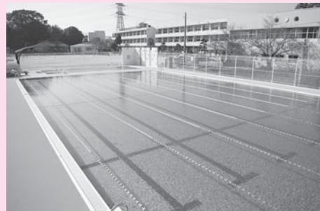
改築を行った筑紫小学校プール
