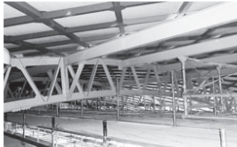
落下防止対策工事中の屋内運動場
