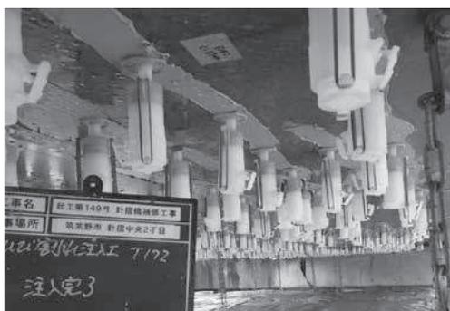
針摺橋(市内針摺中央)の長寿命化のため、橋桁のひび割れ部分に補修剤を注入しました
