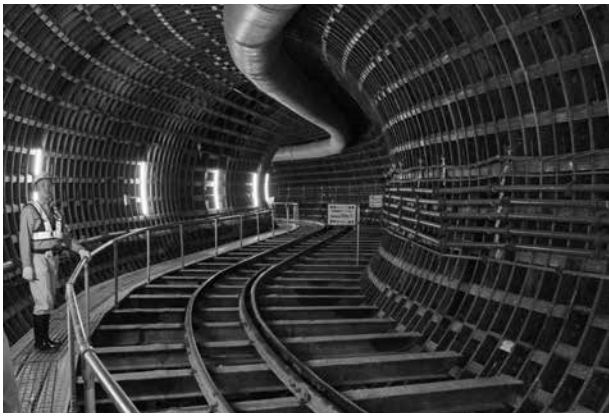
急曲線を描く河川に沿ってトンネルを掘削しています
