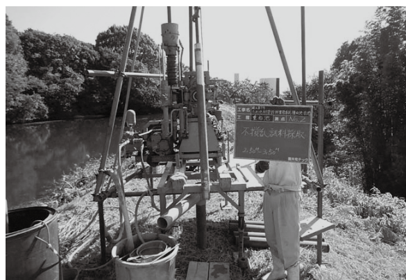
天山の重ね池、岡田の古池の土を採取するなどして耐震診断を行いました
