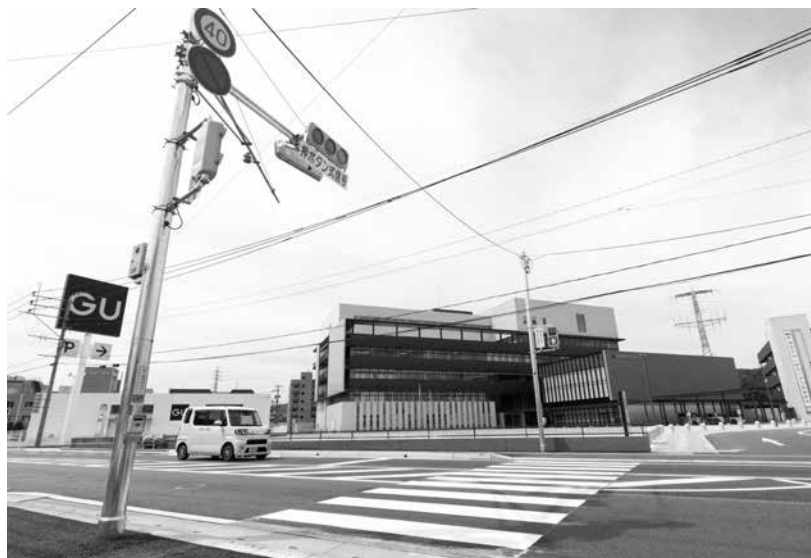
▲設置された信号と横断歩道
