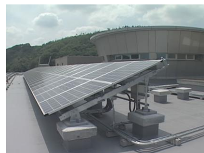
屋上太陽光発電事例 (井原市)
