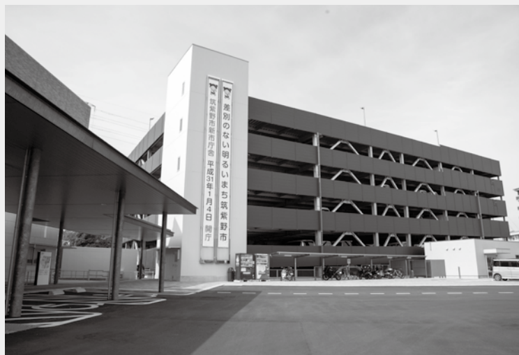
立体駐車場からの通路には屋根があり、雨天時でも濡れずに入館できます
