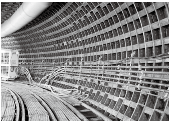
高尾川のカーブに沿って細かく調整しながら掘り進めています
