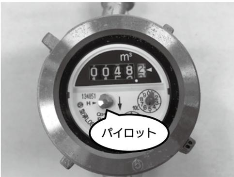
④蛇口を閉めた状態でパイロットが回っていれば、漏水の疑いがありますので、至急、緊急漏水時の水道当番業者（22ページに掲載）に連絡してください。
