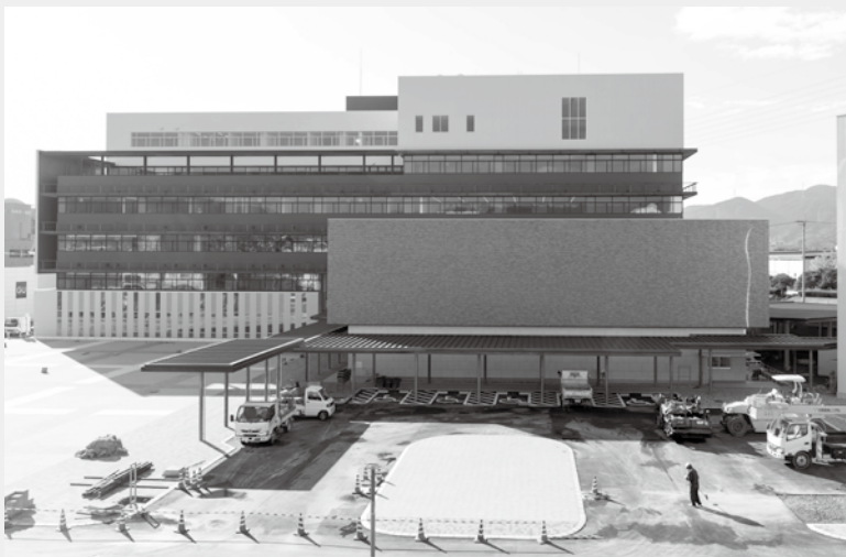
回転広場の工事が完了しました(11月14日撮影)
