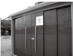
設置された防災倉庫
