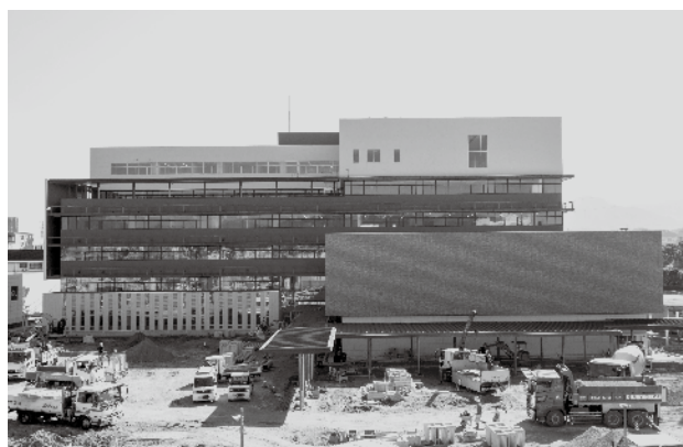
来年1月の移転に向け、市庁舎建設を進めています(10月25日撮影)
