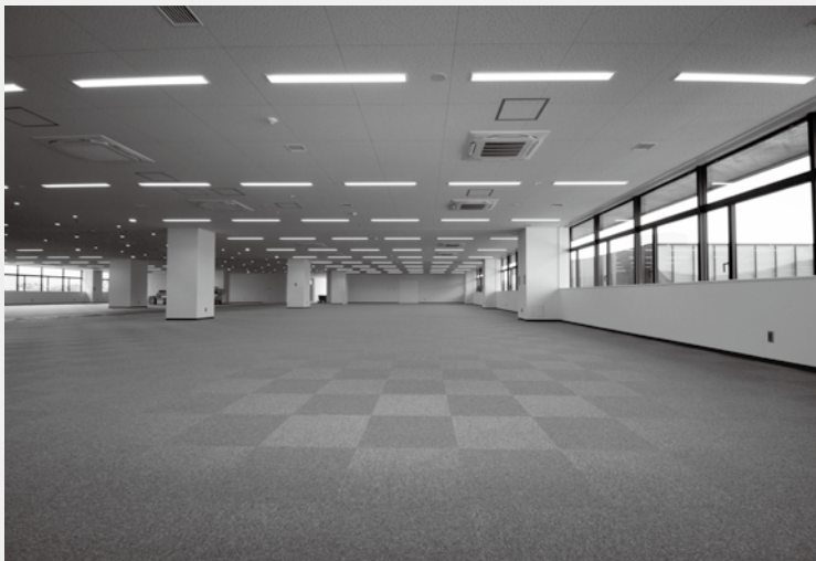
内装工事が完了した3階フロア(10月3日撮影)
