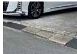
ブロック撤去前
