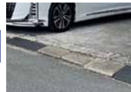
ブロック撤去前
