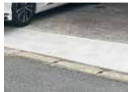
道路の切り下げ工事後
