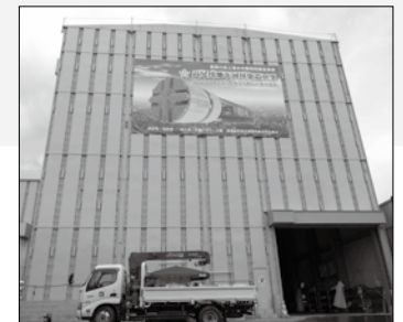
紫橋近くの流入施設
