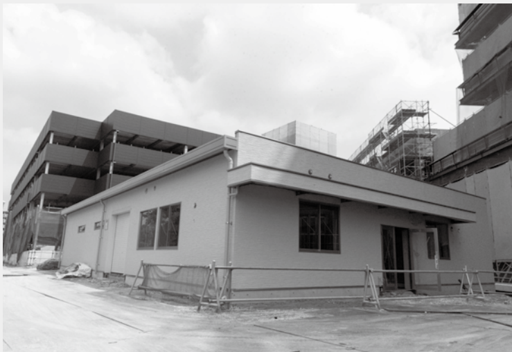
子育て支援センターとファミサポは庁舎棟西側に建築しています
