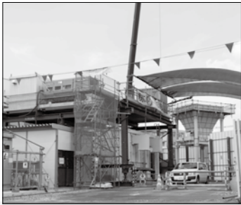
西鉄二日市駅近くで立坑掘削中の流出施設
