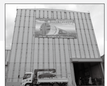
紫橋近くの流入施設
