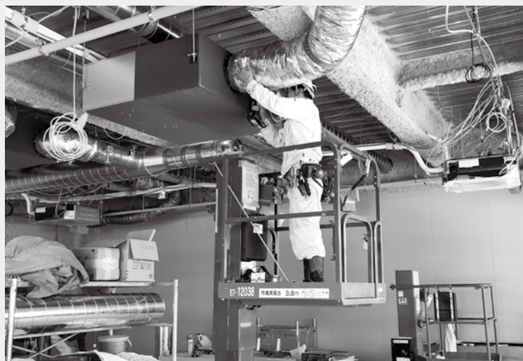
一つ一つの空調機器にダクトや配管を取り付けていきます(7月10日撮影)
