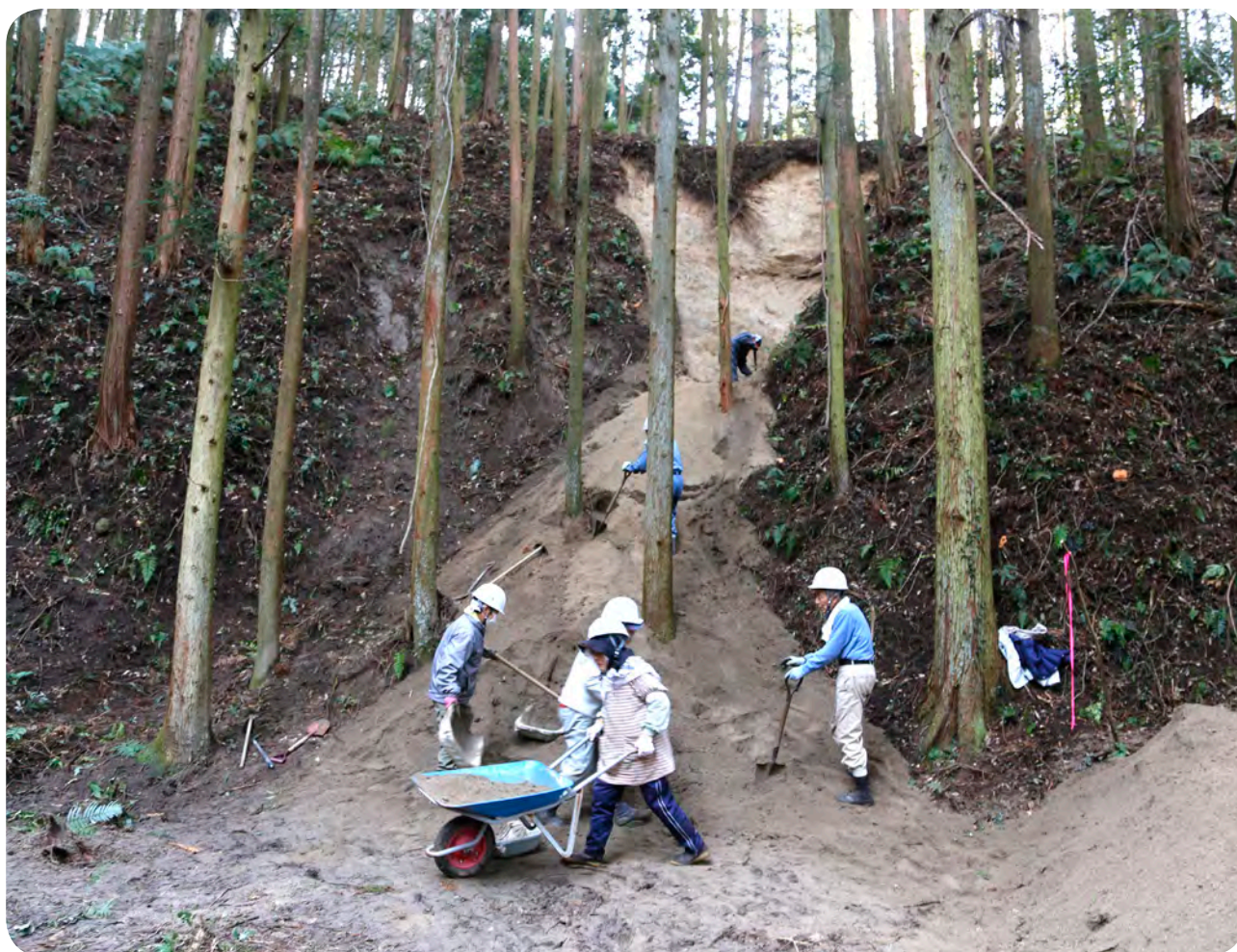
被災現場と復旧・確認作業
