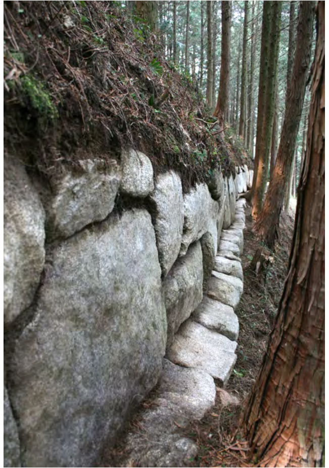
写真 25 基底石延伸状況
