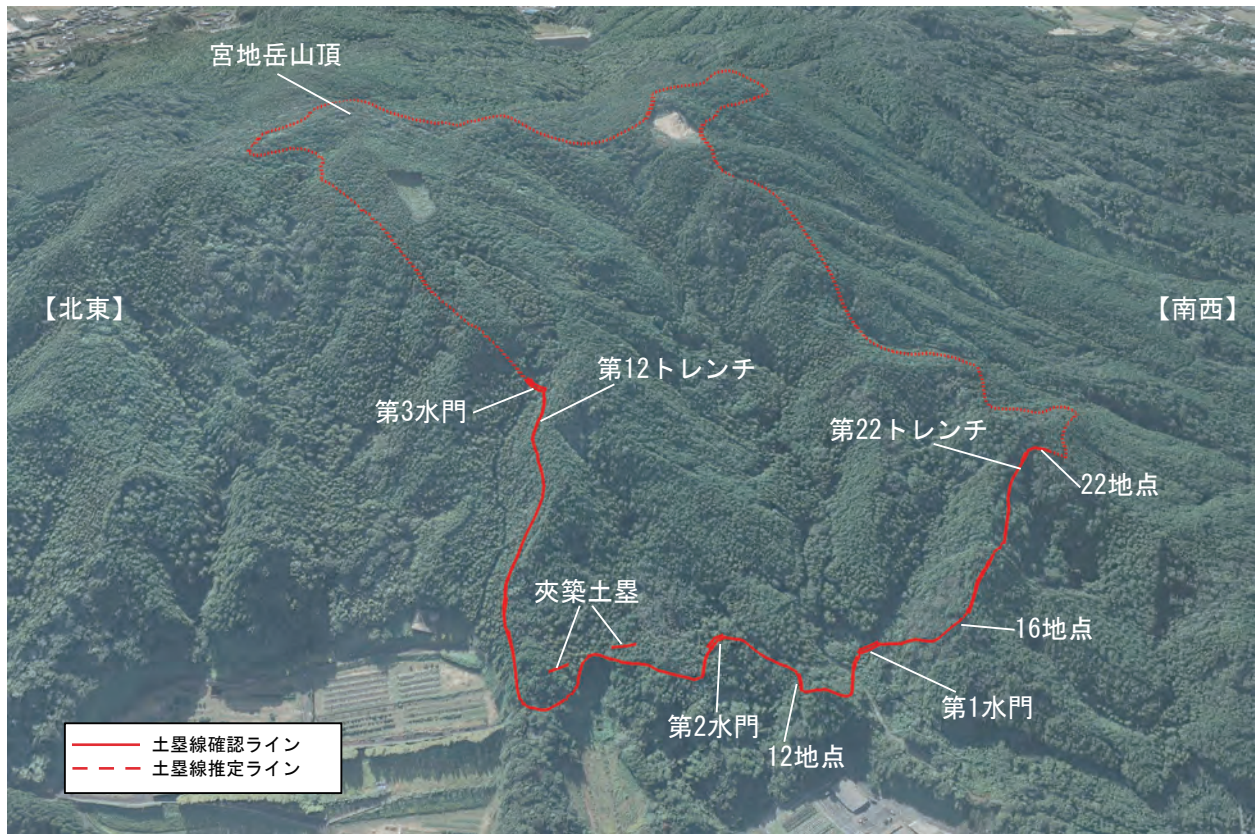
図 22 阿志岐山城跡城域図（航空写真 北西から）
