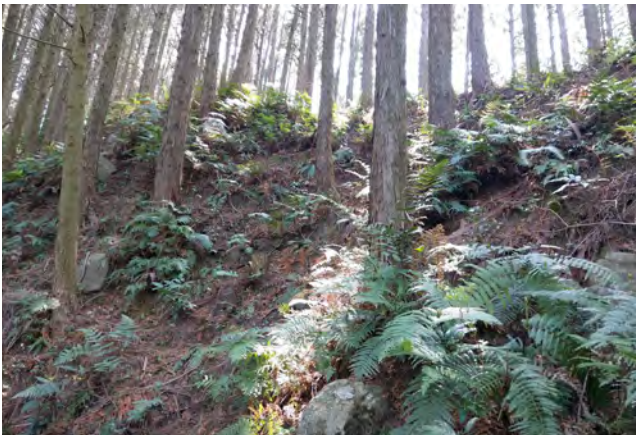
写真 68 ⑱斜面崩壊
