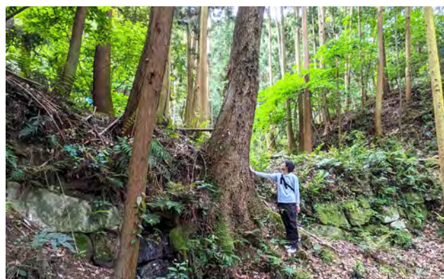
写真 79 第 2 水門に食い込む支障木
