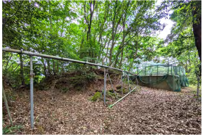
写真 54 福岡県農林業総合試験場取水設備
