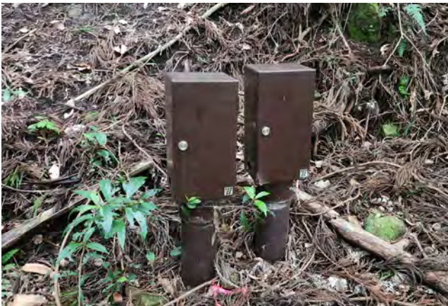
写真 58 高圧送電用鉄塔附帯設備
