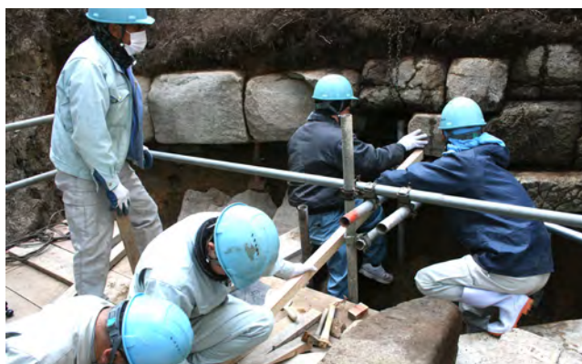
写真 78 第 12 地点保存管理のための整備工事
