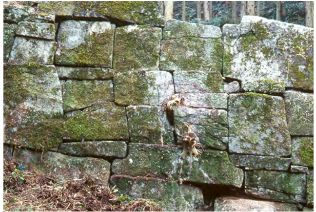
写真 33 第 3 水門石積み (石墨)
