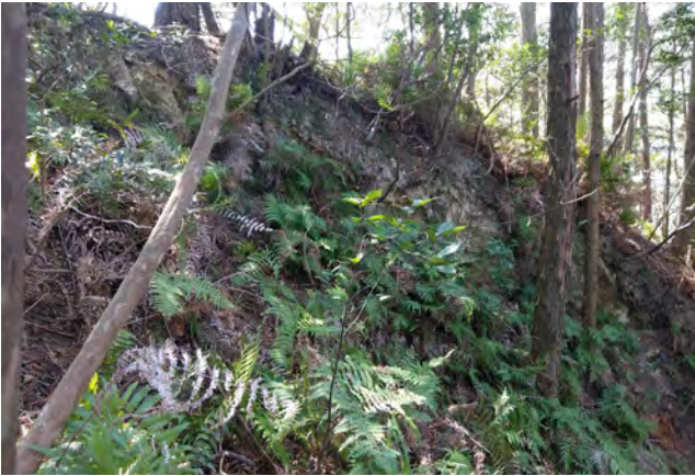
写真 62 ④斜面崩壊 (土塁欠損)
