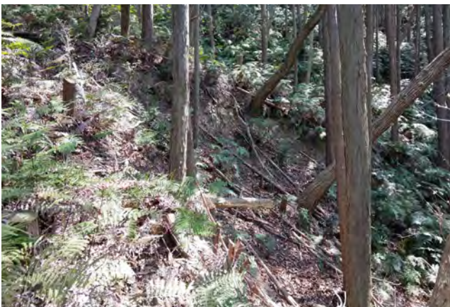
写真 74 ㉖斜面崩壊 (土塁欠損)
