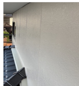
外壁工事施工後
