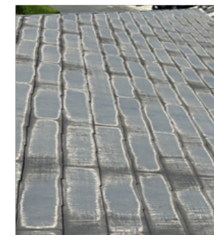
屋根工事施工前
