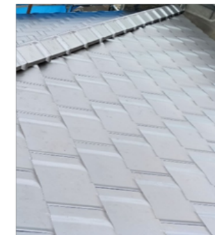
屋根工事施工後
