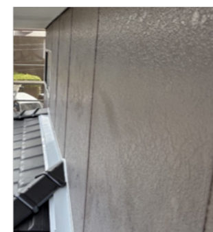
外壁工事施工前
