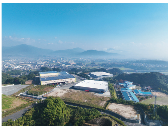
▲筑紫野インターチェンジ付近の流通業務施設 人口・世帯数
