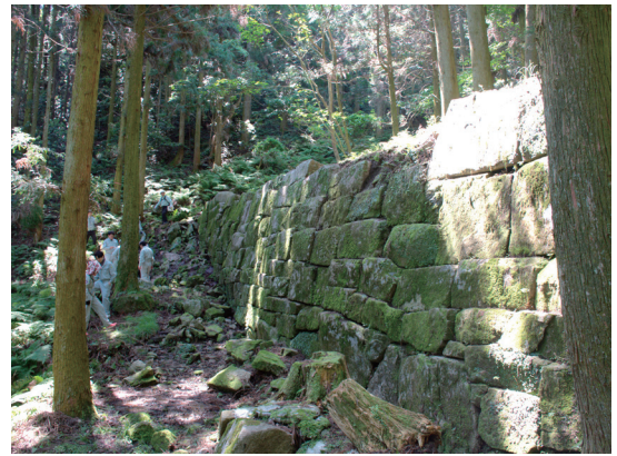
▲阿志岐山城跡 第3水門
