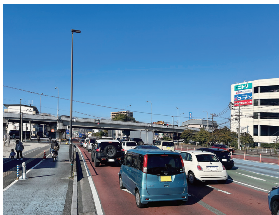
▲交通量が多い針摺交差点付近
