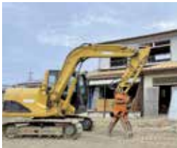
▲解体、除去工事
