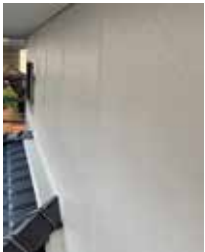
外壁塗装工事後
