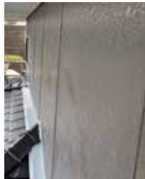
外壁塗装工事前
