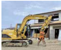
▲解体、除去工事
