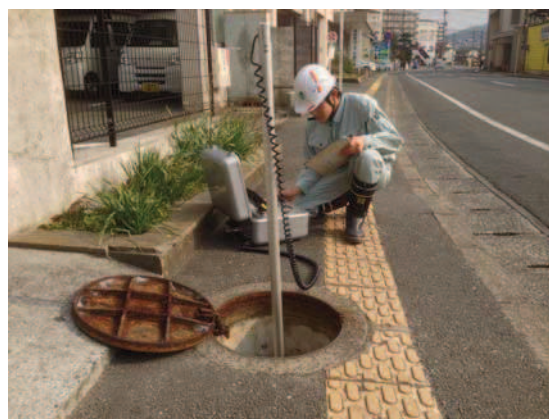
▲下水道施設点検
