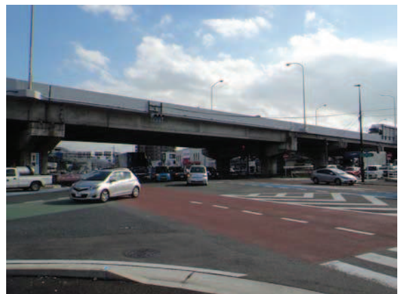
▲交通量が多い針摺交差点付近
