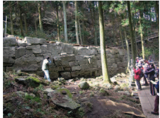
▲阿志岐山城跡 第3水門
