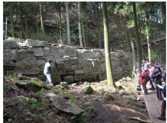
▲阿志岐山城跡 第3水門
