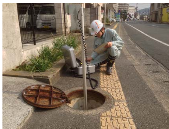
▲下水道施設点検
