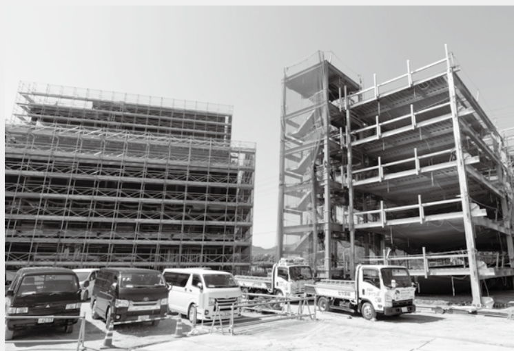
鉄骨組立中の立体駐車場(右側、5月11日撮影)
