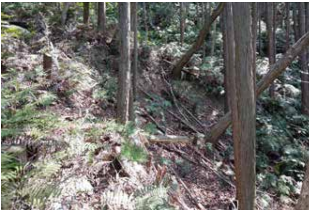
写真 74 ㉔斜面崩壊 (土塁欠損)
