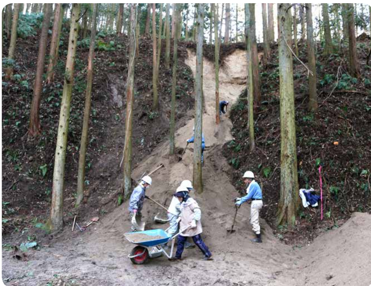
被災現場と復旧・確認作業
