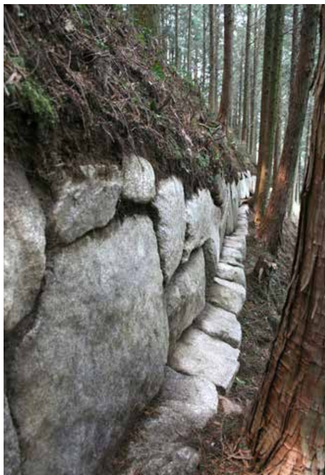
写真 25 基底石延伸状況
