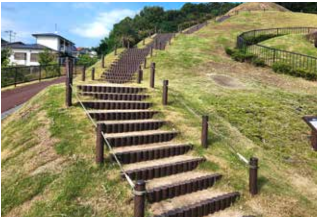
写真 94 擬木階段の例（善一田古墳公園：大野城市）
