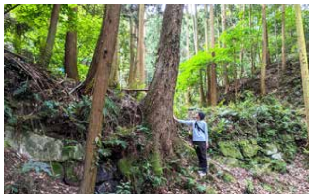
写真 79 阿志岐山城跡 第 2 水門石塁に食い込む支障木
