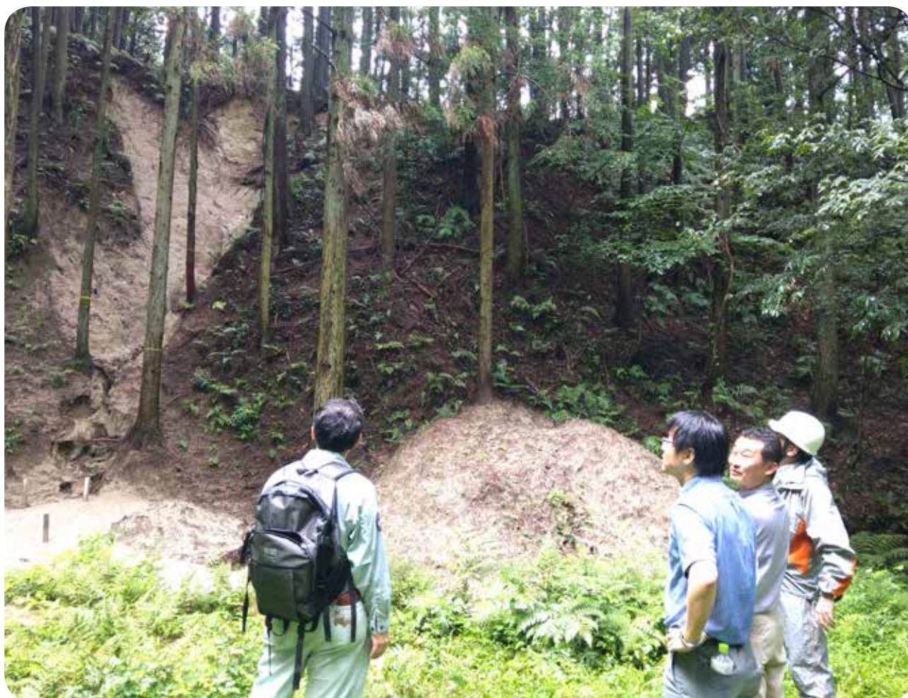
阿志岐山城跡災害現場確認状況
