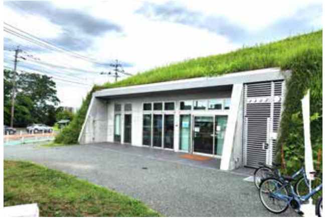
写真 101 便益施設例（水城跡：太宰府市）
