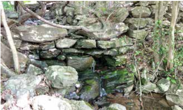
写真 14 城山城水門 (香川県)
