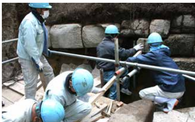
写真 78 第 12 地点保存のための整備工事
