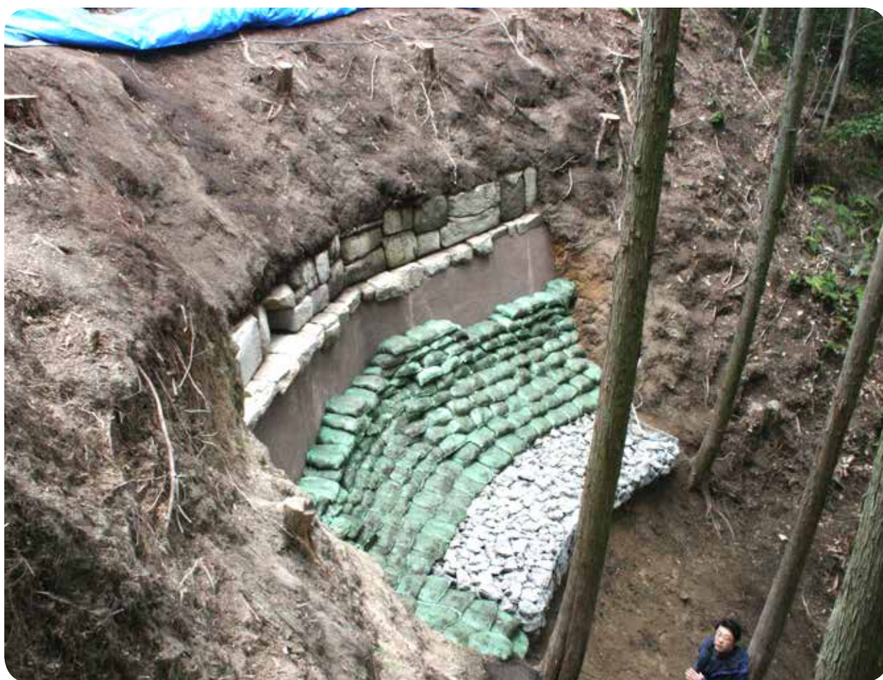
阿志岐山城跡第 12 地点の復旧整備状況
