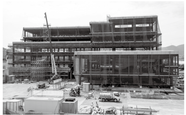
市庁舎建設では、各階の床のコンクリート打設が完了し、配管などの内部工事に着手しています
