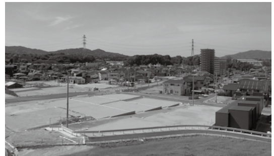
筑紫駅西口周辺で宅地・道路をつくっています
