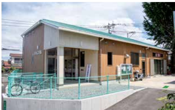
新しく完成した公民館
