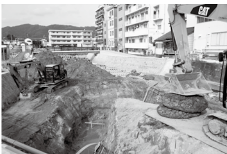
川幅を拡幅する工事を行っています
