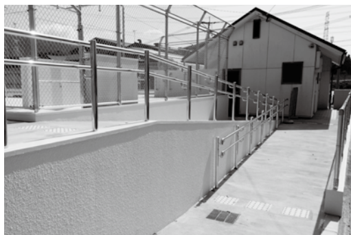
スロープによりスムーズにプールに行けます
